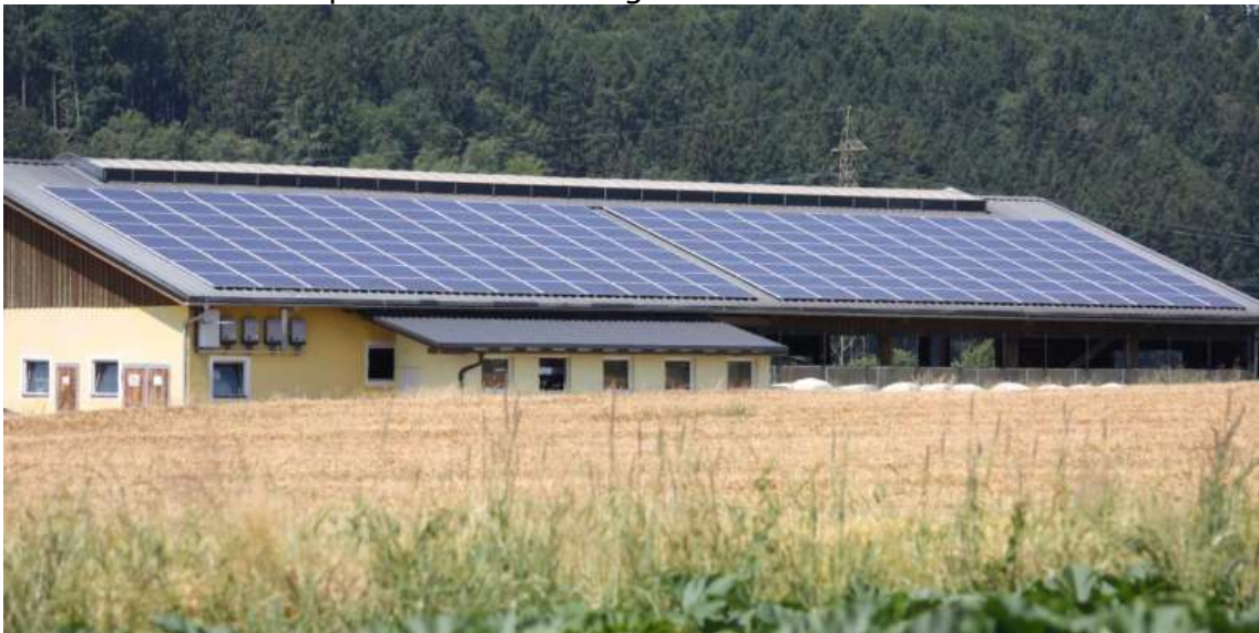
Bild 1: Stall der Fam. Spath mit PV Teilanlage
